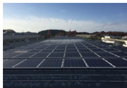
太陽光パネル
