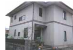
住宅防音工事前
