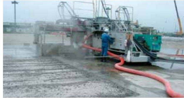
完全付着型オーバーレイ工法工事の様子
