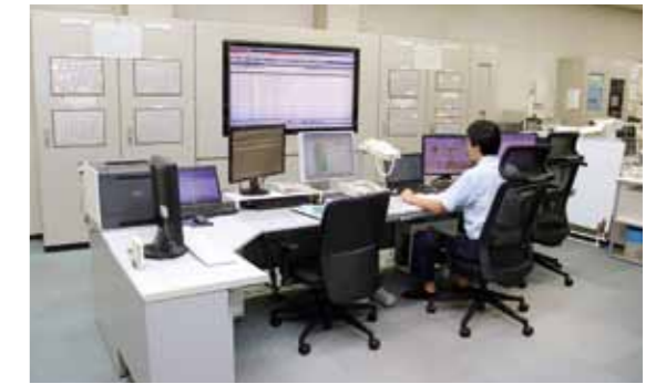
第2旅客ターミナルビル内の中央監視室
