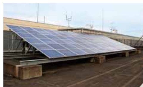
NAA本社ビル屋上の太陽光発電パネル
