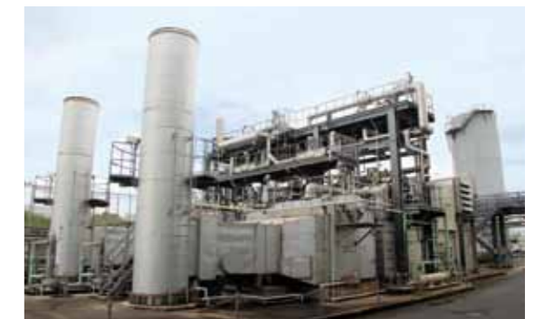
コージェネレーションシステム
