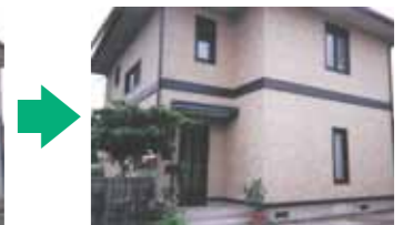
住宅防音工事後 (防音ドア、防音サッシなど交換)
