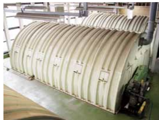
厨房排水除害施設
