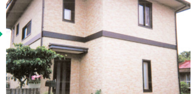
住宅防音工事実施後（防音ドア、防音サッシなど交換）
