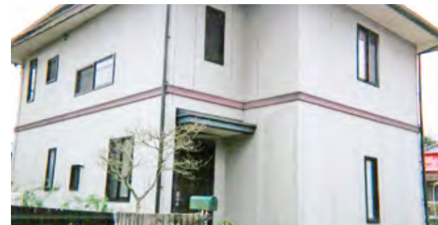
住宅防音工事前
