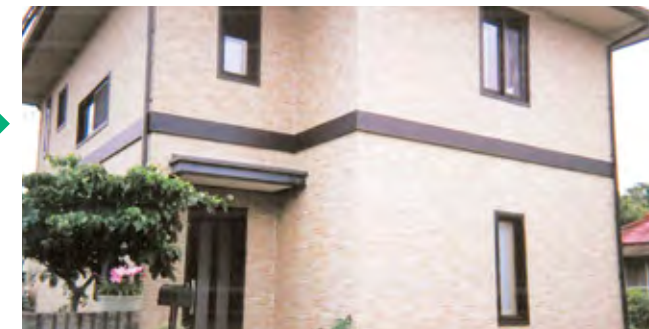
住宅防音工事後(防音ドア、防音サッシなど交換)
