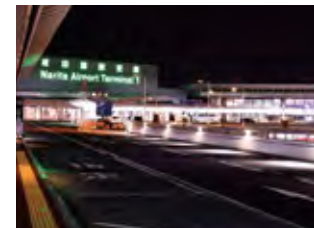
第1旅客ターミナルビル 出発カーブサイドLEDサイン
