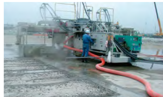
完全付着型オーバーレイ工法工事の様子
