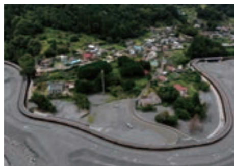
雨畑ダム上流域の堤防（2021年8月撮影）
